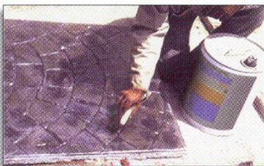
5 Una vez que el concreto se encuentra completamente libre de humedad (seco), aplique sellador sobre la superficie terminada usando un aspersor o pistola de aire.
