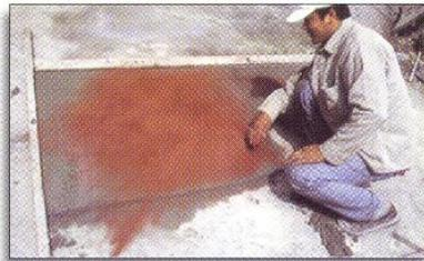
2 Espolvoreé Color Endurecedor a razón de 2 Kg. por m<sup>2</sup>. Pula el concreto con "Llana de Magnesio" para integrar el Color Endurecedor al concreto. Espolvoreé nuevamente Color Endurecedor a razón de 1 Kg. por m<sup>2</sup> para retocar la primera aplicación, integre el Color Endurecedor, puliendo nuevamente con "Llana de Magnesio". Una vez integrado el Color Endurecedor de manera homogénea / regular en el concreto, pula con "Llana de Acero" hasta dejar lo mas liso posible el concreto.
