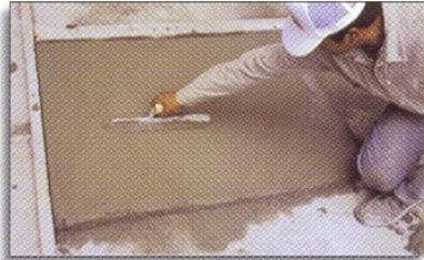
1 Vierta el concreto en la superficie a estampar, enseguida dispérselo, reglé y nivele. Espere a que el concreto alcance su fraguado inicial y que el exceso de agua haya desaparecido.
