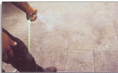
4 A las 24 horas o antes de ser posible, realice cortes con Disco de Diamante para corte de concreto. La distancia entre cortes **NO** deberá ser mayor a, 28 veces el espesor del concreto. La profundidad de los cortes deberá ser entre 1/4 y 1/3 del espesor del concreto. Después de 72 horas lave al gusto con agua a presión o con cepillo para quitar el exceso de Desmoldante.
