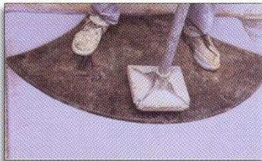
3 Espolvoreé Desmoldante cubriendo el concreto con una capa delgada. Inmediatamente coloque el molde sobre la superficie, golpeando en la parte superior uniformemente para lograr el grabado.
